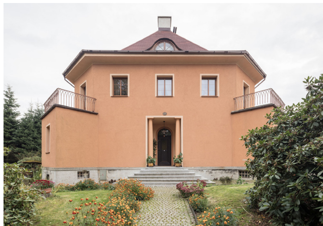
Dům A. Richtera, vstupní průčelí, stav 2020, foto: Till Schuster
