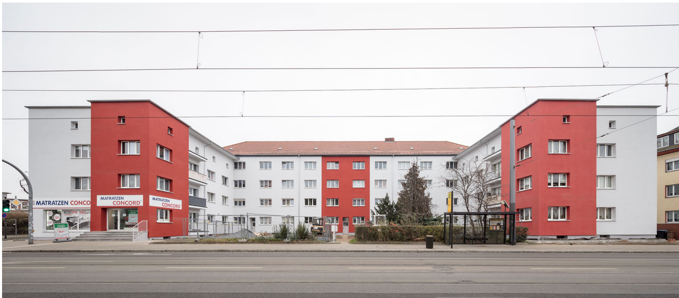
Frenzelovy domy po rekonstrukci, prosinec 2020, foto: Till Schuster
