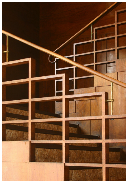
Vila Palme, zábradlí schodiště v hale, stav 2006, foto: Marta Pavlíková
