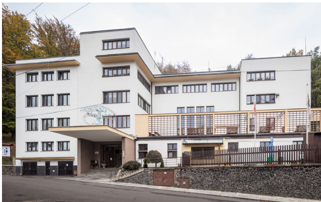
Vila Palme, hlavní vchod s vysutou markýzou, stav 2020, foto: Till Schuster
